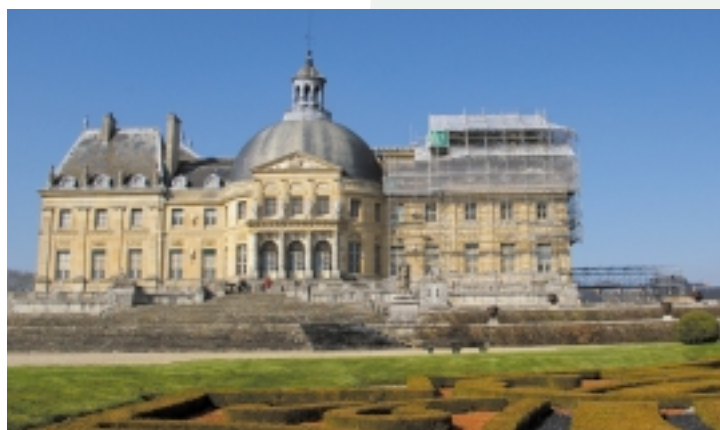
Échafaudage Mills Acram utilisé pour restaurer les toitures du prestigieux château de Vaux-le-Vicomte.
