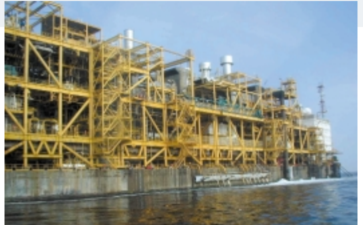
La barge de production NKP est l’une des plus importantes installations pétrolières : sa surface est de 220 m x 46 m. NKP is one of the largest production barge (220 m long and 46 m wide).
